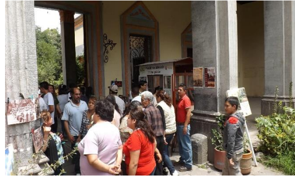
Pórtico, entrada principal. Vendedores utilizando columnas y pared para colocar sus letreros.
